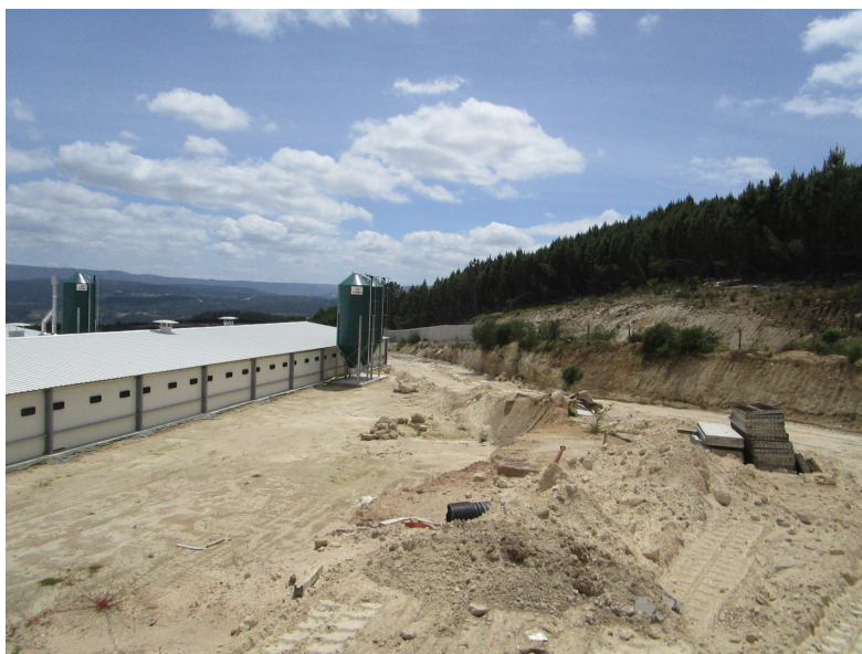
Figura 2 - Vista geral dos pavilhões já construídos e dos acessos (solo artificializado)
